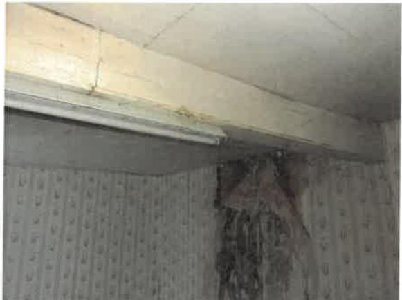
L'accès au grenier se fait par un escalier étroit envahi par les fientes d'oiseaux . Ce niveau permet de confirmer le très mauvais état de la charpente et de la toiture et des nombreuses infiltrations d'eau conduisant au très mauvais état des étages inférieurs.
