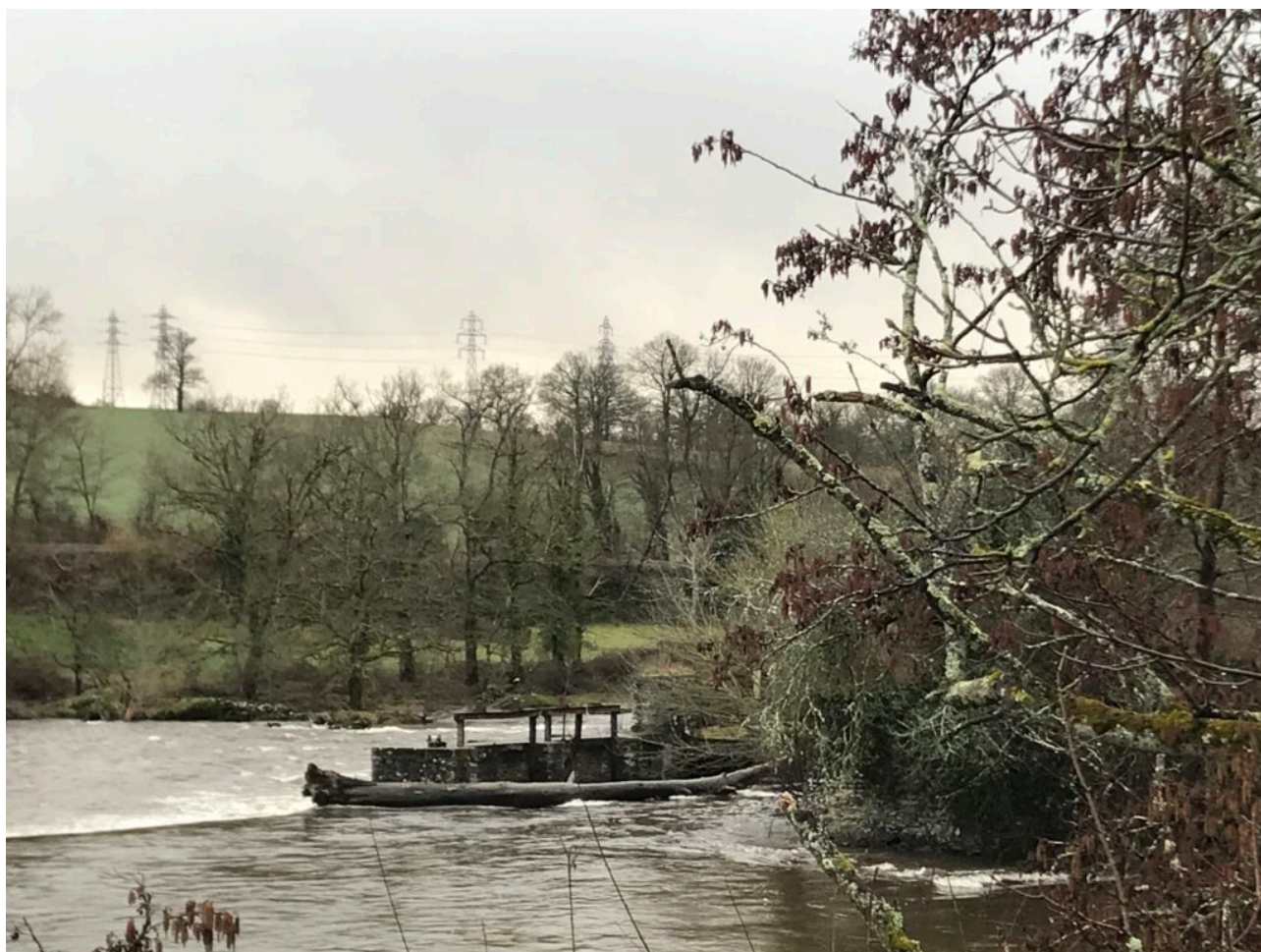
Vue de l'amont (depuis la rive droite)
